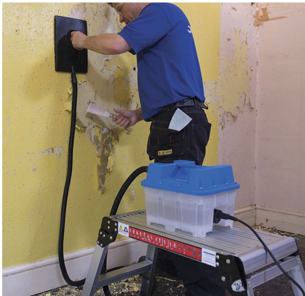
Použití parního odstraňovače tapet
